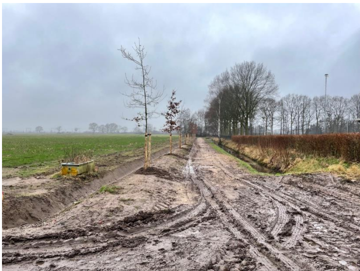
Werkzaamheden in uitvoering aan de Zomerdijk (foto: Henk Smouter)
