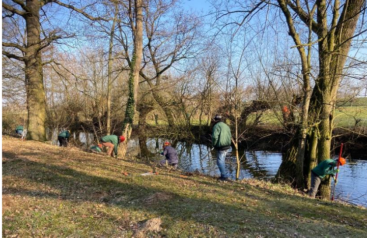
Werkzaamheden aan het hoornwerk (foto Hans Hamersma)
