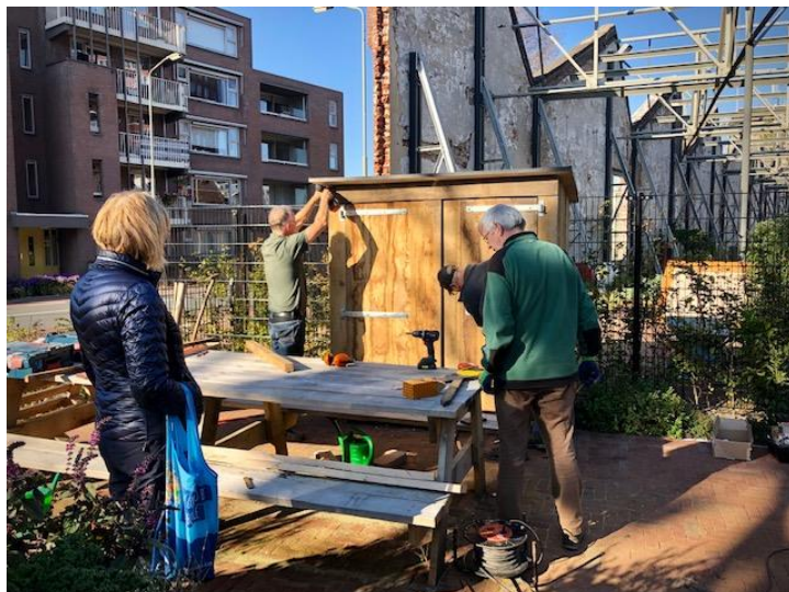
Een van de twee gereedschapskasten in aanbouw (foto: Ton Oomen)
