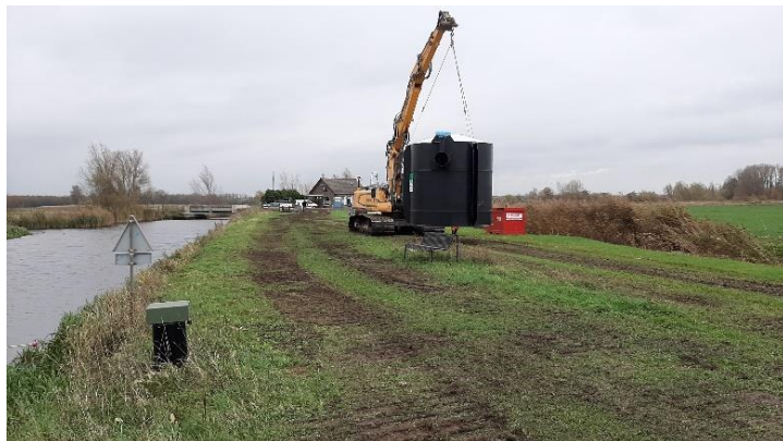
Aanleg vislift bij de Hertogswetering bij de "Oijense Hut"
