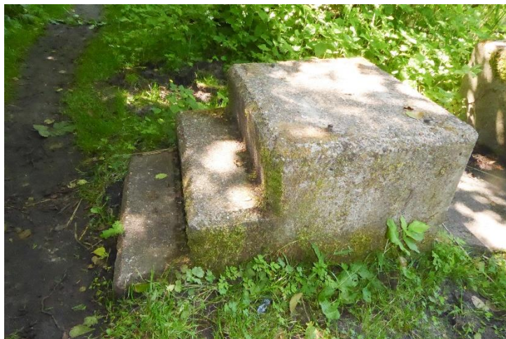
De betonnen dragers van de duikplankenplanken zijn de enige zichtbare restanten van het oude zwembad (foto: Dick Roza)
