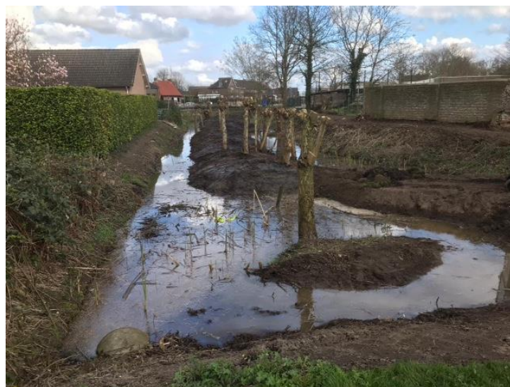
Recente graafwerkzaamheden bij de Eilandjes in Lithoijen (foto: Tonnie van Hooff)
