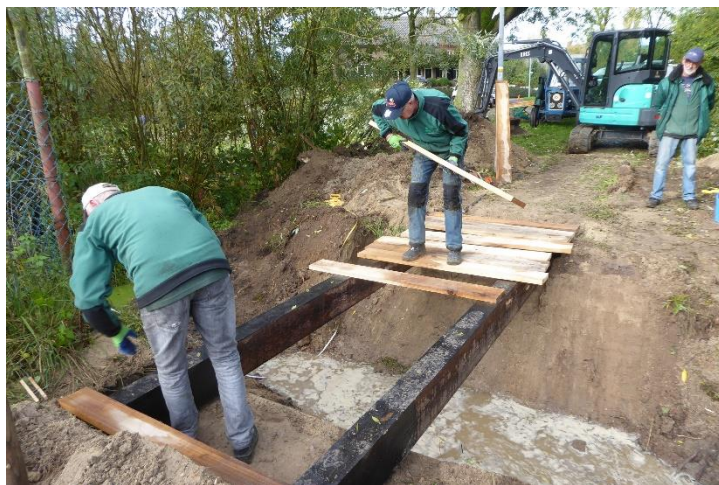
Aanleg van de brug (foto: Frans Heeren)
