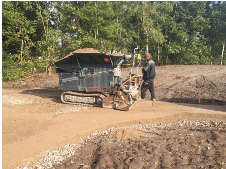
Aanleg voetpaden met op afstand bestuurde machine in herdenking bomenbos.
