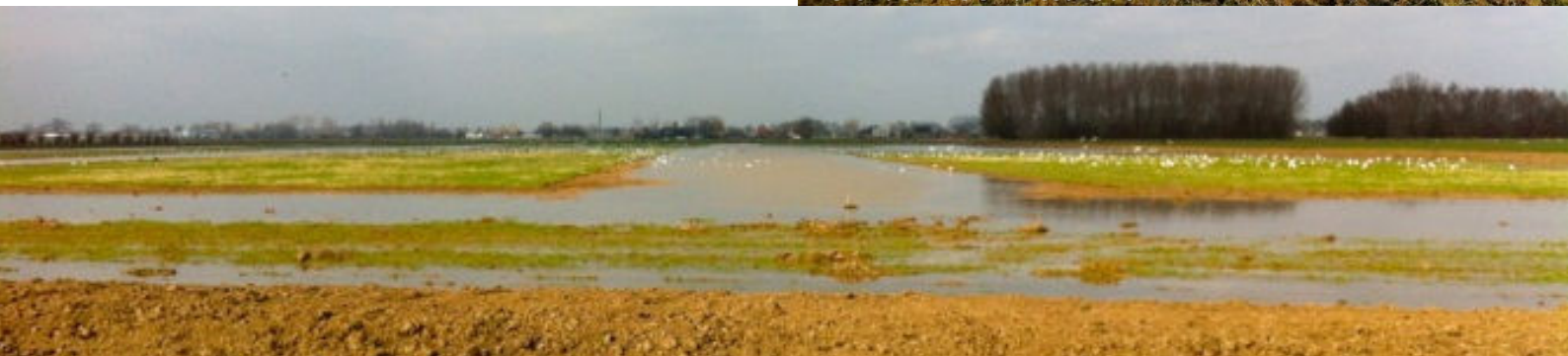
Aanleg plas-dras situatie bij Mareense eendenkooi. Hieronder het eindresultaat!
